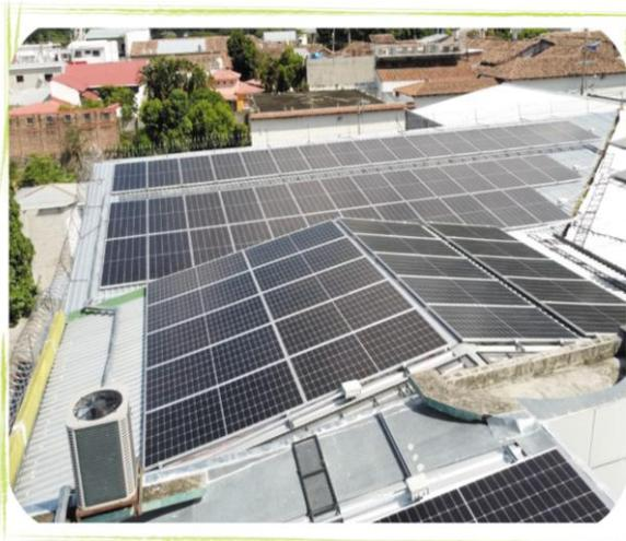
También como parte de cuidar el medio ambiente, la Caja de Crédito de Chalatenango ejecutó en junio de 2023 el proyecto Fotovoltaico “Ingeniería, Diseño, Instalación y Puesta en Marcha de Generación de Energía Solar de Paneles Fotovoltaicos” en las instalaciones de la Caja de Crédito de Chalatenango: 6ª. Calle Poniente, Barrio El Chile, Departamento de Chalatenango, logrando un ahorro de consumo de energía.
